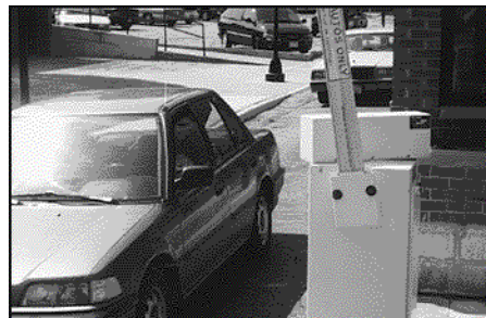
Figura 69. Un Sensor Fotoeléctrico Evita que los Coches Siguiendo Pasen por la Caseta Gratuitamente
