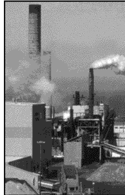
Figura 12. Interruptores Limitadores Trabajan en Lugares en Donde la Gente No Puede
